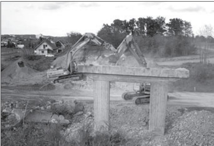
Nadvoz pri Turnišču je »padel« v začetku maja, gradijo pa že novega.
