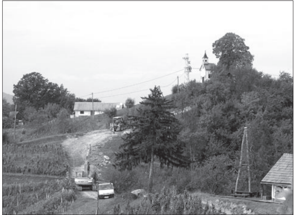
TM V haloškem Skorišnjaku smo v začetku oktobra preverili, kako poteka gradnja vodovoda.
